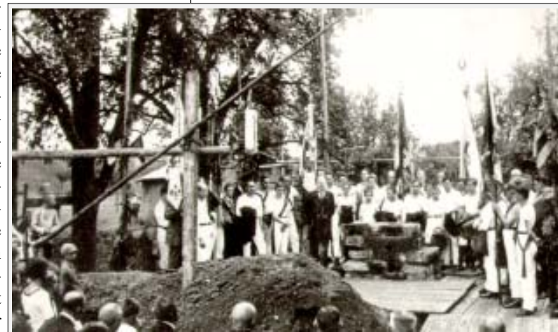
Grundsteinlegung der alten Jahnhalle
